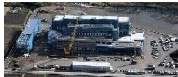
建設中の利根中央病院全景
